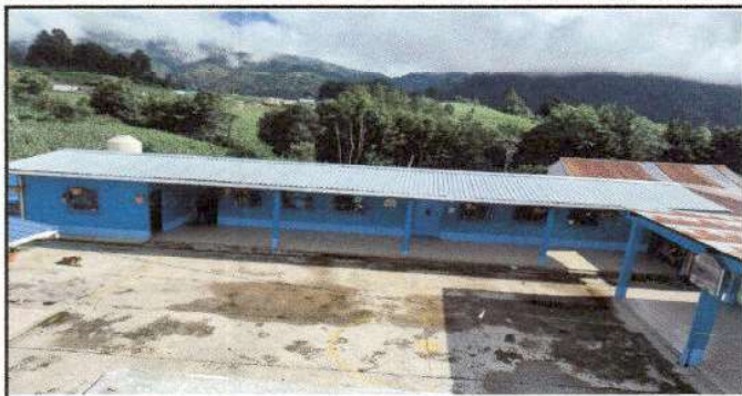
Foto1: Sustitución de lamina Troquelada y costanera
