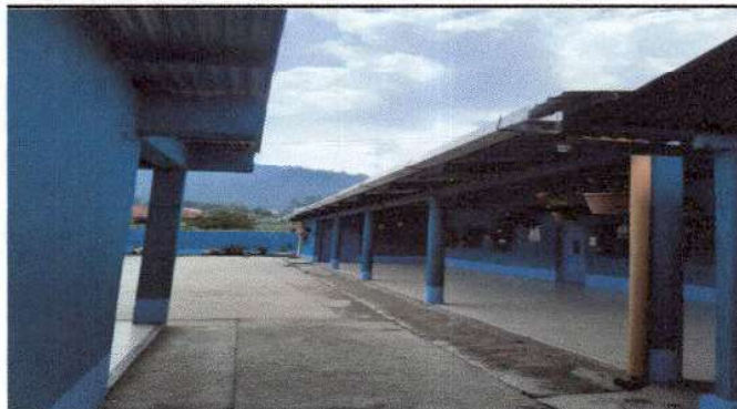
Foto 2: Sustitución de canal PVC
