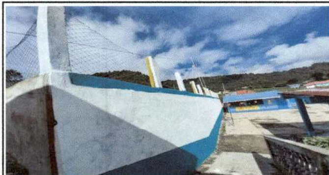
Foto 3: Pintura en muro interior
